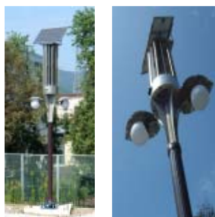
写真3. 小型風力発電による街路灯
