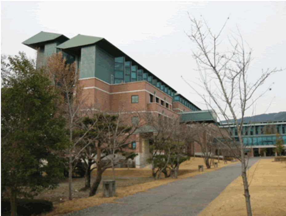
図 4 - 5 実際に撮影した A 棟
