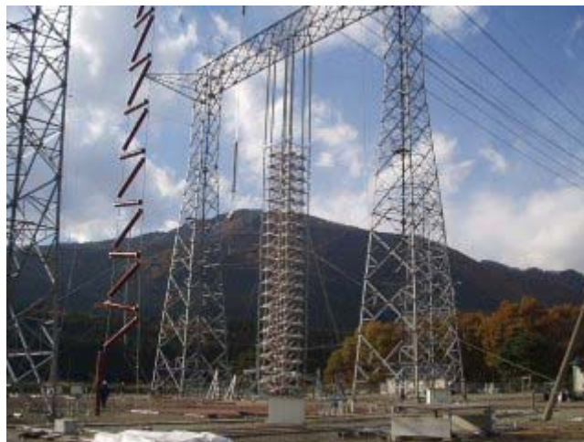
Fig.8 塩原実験場の衝撃電圧発生装置の外観
