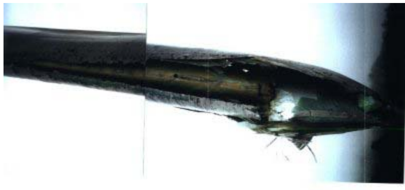
Fig.3 大豊風力発電所 1999 年 9 月 15 日の被雷でのブレードの損傷状況その 1
