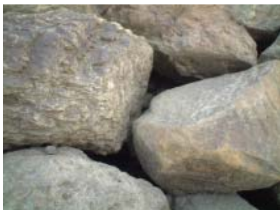
巨石積み護岸空洞部分（完成後2年経過）
