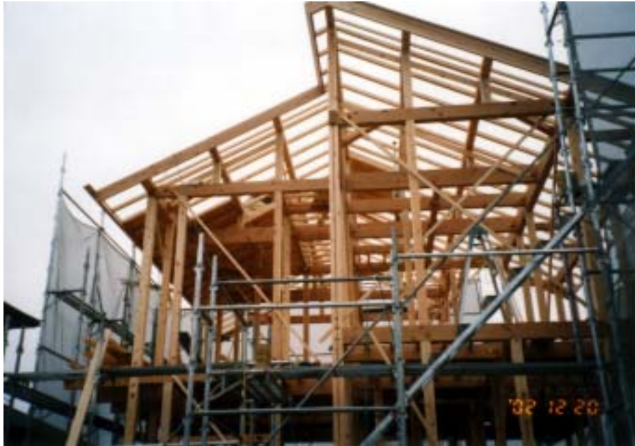
Fig.3-1 在来工法による住宅建築の様子(高知市内)
