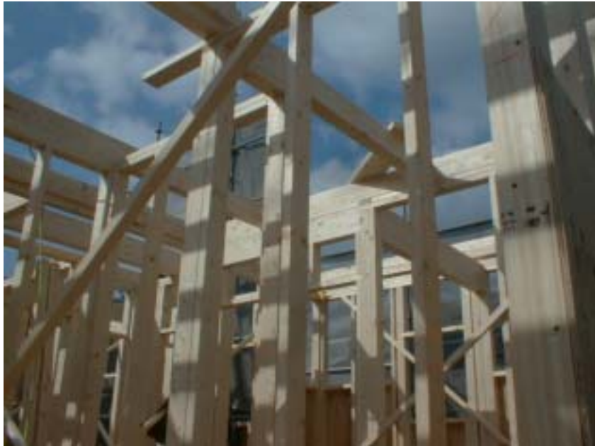
Fig.3-3 高知市内の2×4工法の住宅建築現場
