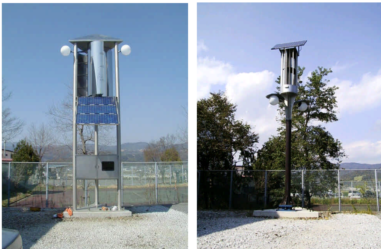
図 2 太陽光・風力ハイブリッド発電システム
