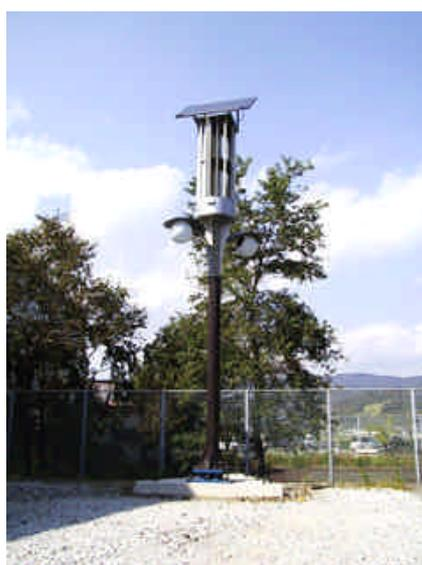
図.1-2 自立型街路灯「Twinkle」と内蔵されている 250mm 発電機
