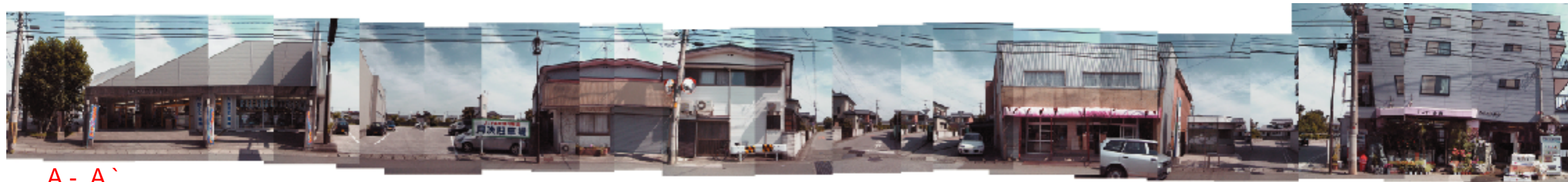
土佐山田町 商店街立面写真 No.6 (西本町南側2)
