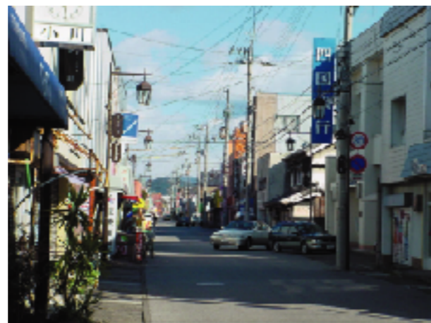
現況写真 11：目立つ電柱電線
