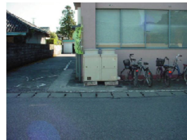
現況写真 13：無造作に置かれている室外機
