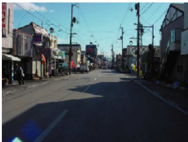
統一感のない建物や電柱により、景観を阻害している。
