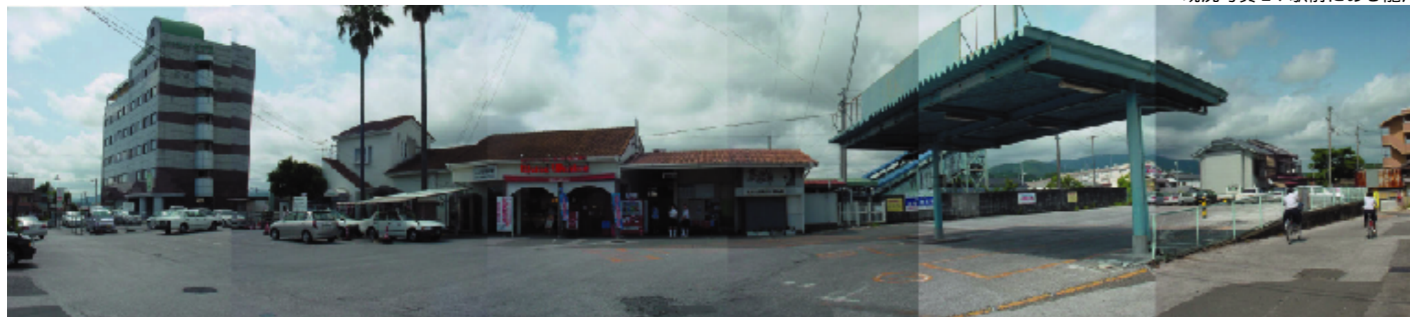
現況写真 4 : 駅前広場を望む
