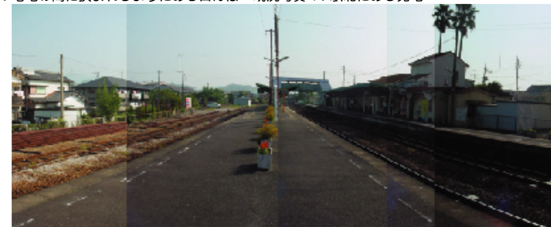
現況写真 6：駅ホームより
