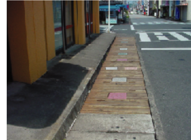
現況写真 4：商店街の水路の蓋
