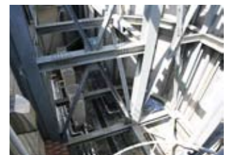
写真上: 写真の右手には雪ヶ峰牧場、正面の山の右手には太平洋が見える。写真下: 緑の屋根の内部。空調や給水設備が配置されている。
