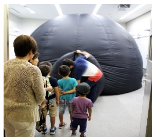
換気扇で膨らませる直径5mの布製エアドームからなります
