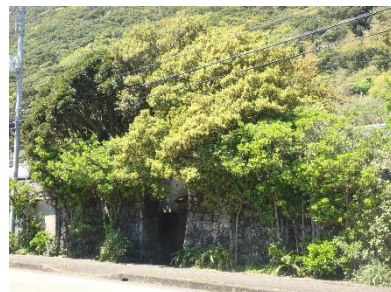
暴風壁の石垣が敷地を囲む“突然変異”の民家 (室戸岬)
