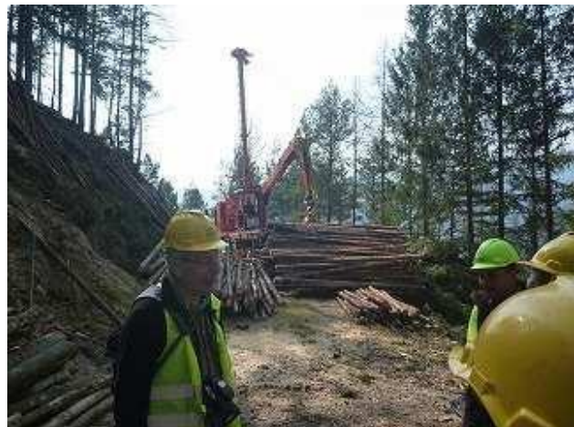
②集材作業中のタワーヤード
