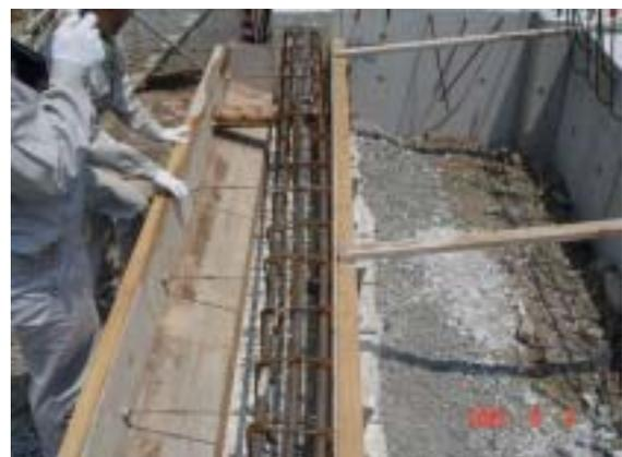
写真1：施工ミス確認かぶり厚さ0cm
