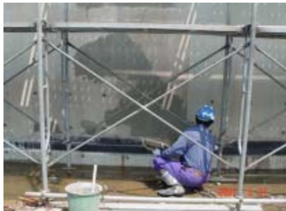
写真 3 : ジャンカ補修状況
