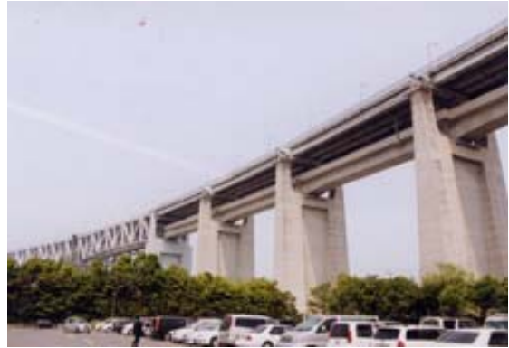
写真 1. 番の洲高架橋
