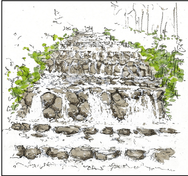
① 階段工により生まれたカスケード（階段状の水の流れ）。今回の河道デザインの基本となる流れ。野面石の間を縫うように流れていく。
