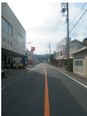
図 6) 国道 321 号線 拡幅計画により左右の建物は取り壊され、新しい景観が造られる。
