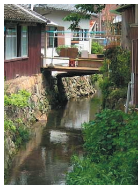
図 7) 弘見河 都市部に見られる石積み護岸。コンクリート護岸はこの写真の様な石積みとするか、土地買収が可能であれば土手を設ける事とする。
