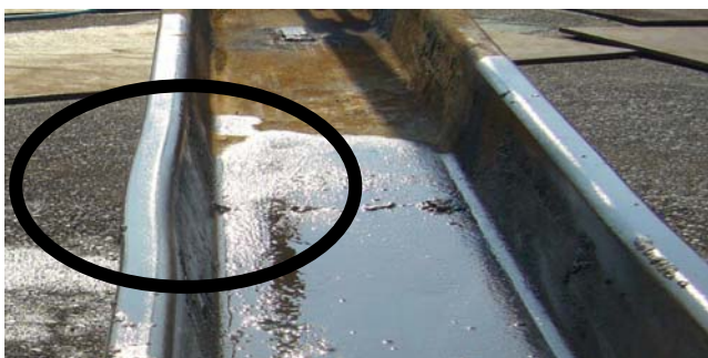
写真2 シートパイル座屈破壊の様子
