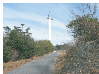
野市風力発電所
