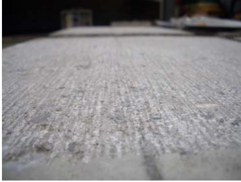
写真-4 「小叩き仕上げ」の表面性状
