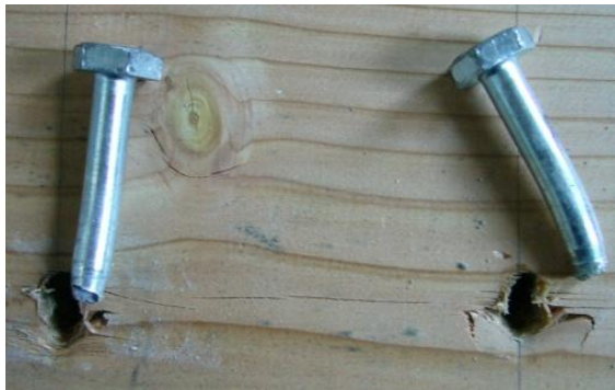
図 2-5-6 折れたボルト
