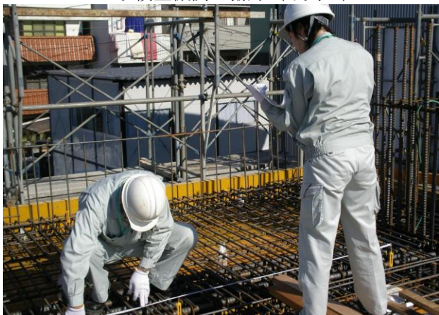
写真4 ERIの検査の様子
