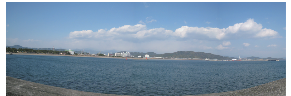
現況写真パノラマ② 堤防の上から撮影したもの。千松公園が見える。堤防の幅はかなり広い。
