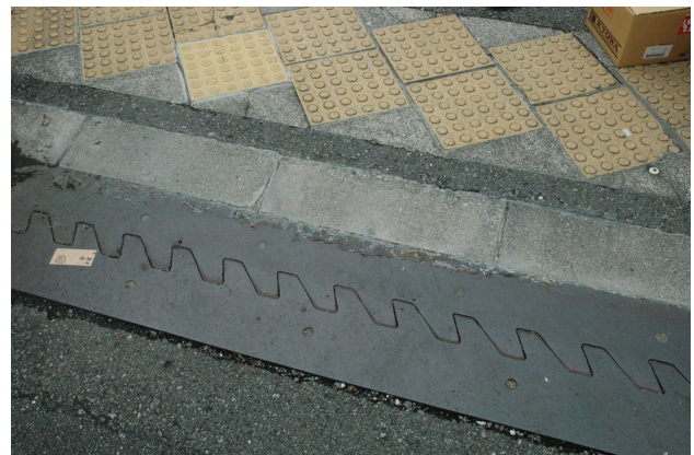
写真1 伸縮装置の遊間
