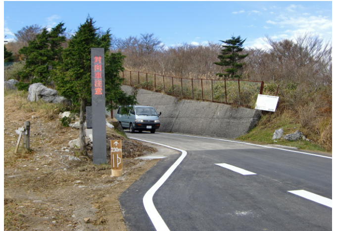
写真 3.2 中山間道路走行支援システム
