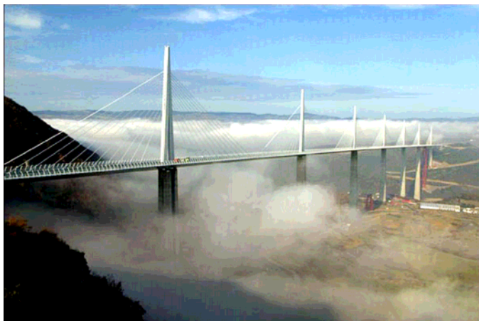
写真 1-1 フランス ミヨー高架橋 (エファージュ社ホームページ)
