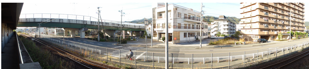
敷地周辺写真
