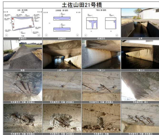
図 8-2 橋梁点検マップ(2)
