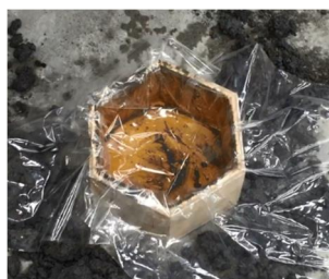
図-9 充填前型枠(ビニール袋)
