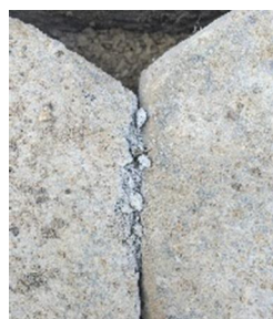
図-16 隣接するブロックの摩耗による欠け
