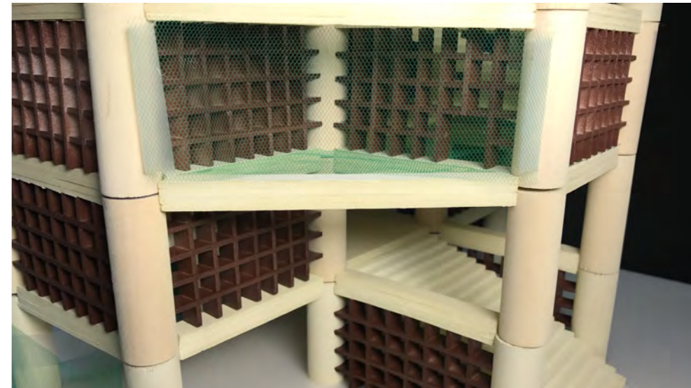
避難経路となる階段は木製の格子で囲うことにより経路を明確にすると共に外観を和らげる効果が期待される。
