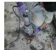
図-5 バイブレータによる締め固め
