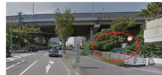
図2. 敷地現状写真
