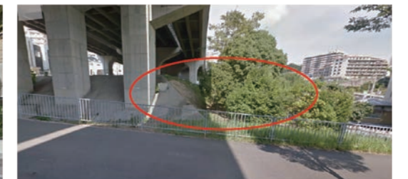
図3. 敷地現状写真
