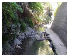
図3:新佐岡橋周辺擁壁
