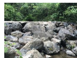
図5:半崩壊状態の堰
