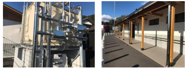
図 8-3 道の駅 南国風良里の防災設備(筆者撮影)
