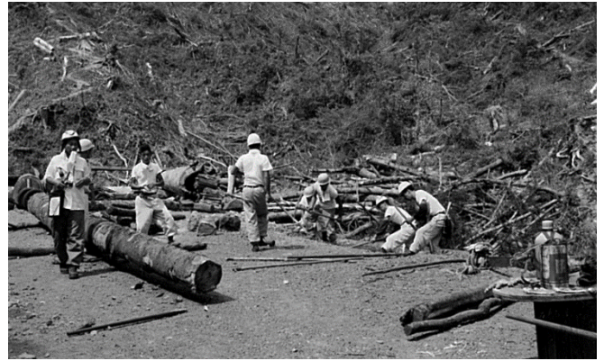
図2. 足川山における伐採の様子（昭和32年当時）
