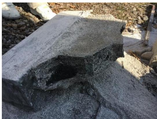
写真-4 コンクリートブロックと目地材の一体化
