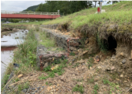
図5.むき出しのカゴマツトと掘削された斜面
