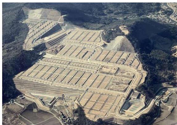
（写真1）建設当時の潮見台ニュータウン（潮見台公民館より）
