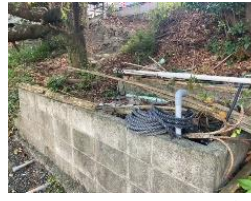
図8 コンクリート土台
