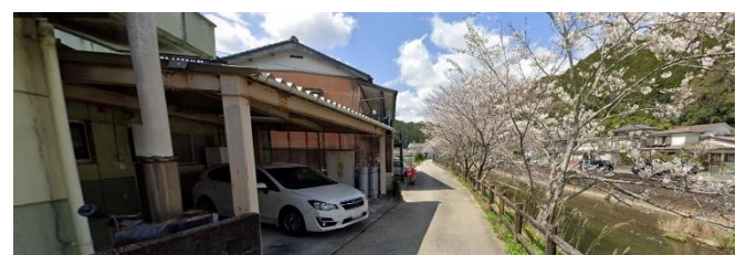
図3.遊歩道と堤防の現況
