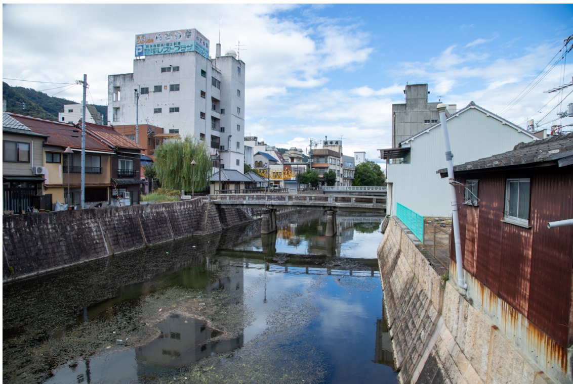
図 1-2 金倉川に背を向けて建つ建物
