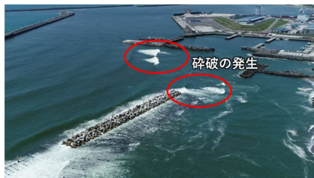
図10，碎波の発生箇所
