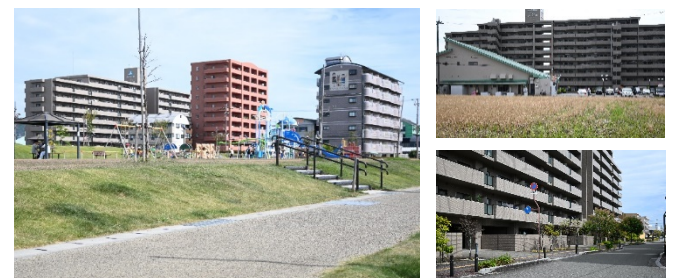
図 2. 公園から見た対象敷地（左）と 敷地内の集合住宅（右）
