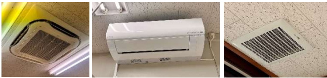
図 9 空調・換気機器例
