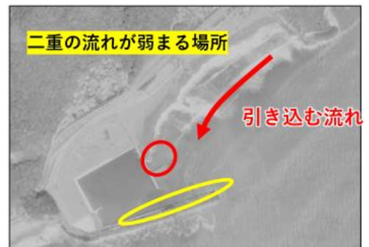
図 2.春野漁港の建設後期 1997 年
