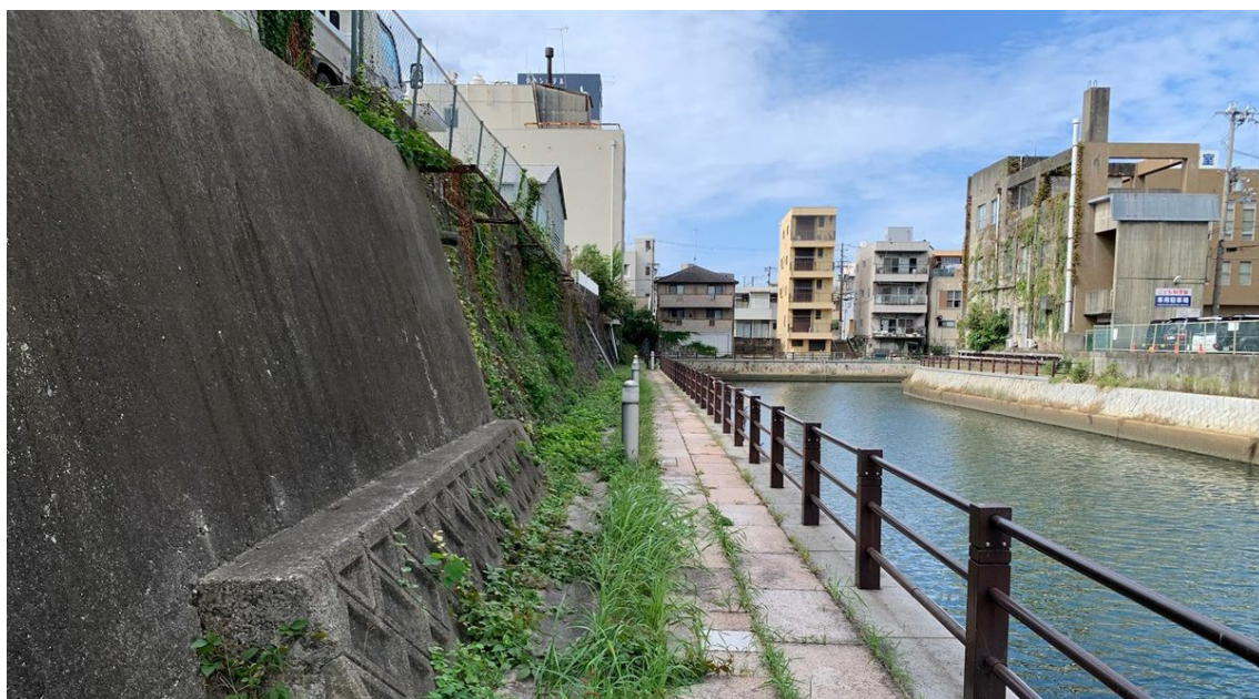
図 7-13 寄合橋・城北橋エリアの現況
