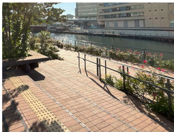
手すりの柵 横浜市役所
