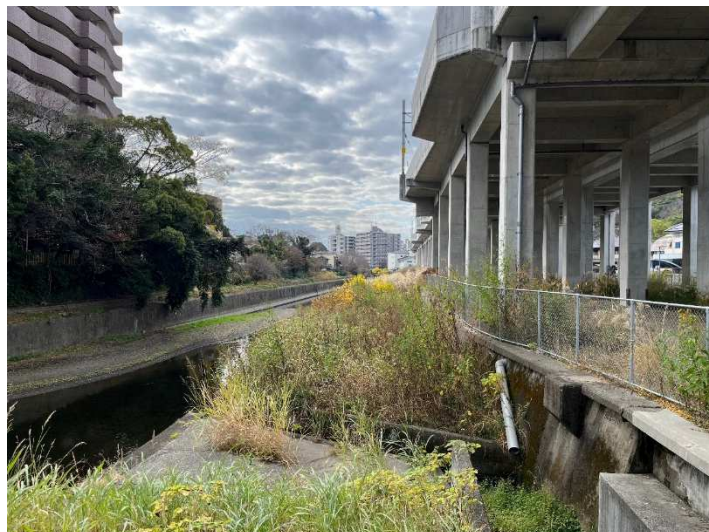
図 2-5 坪井川と高架が並走する区間
