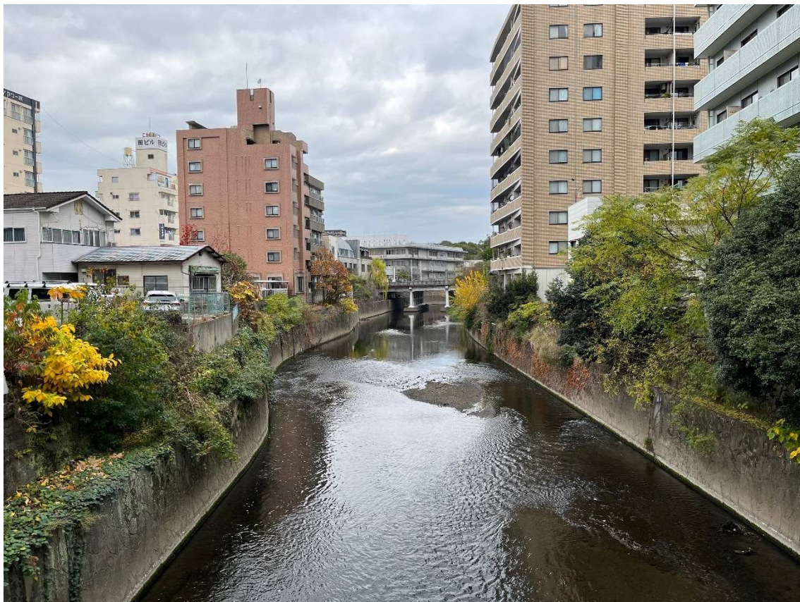
図 1-2 現在の護岸の様子
