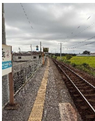
図 2. プラットホーム
