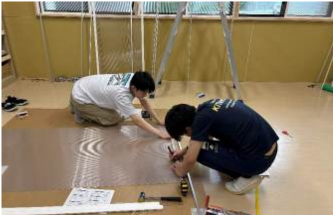
図 8 内窓セルフ施工の様子
