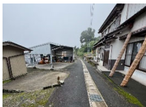
図6 道と同じ高さの住宅
