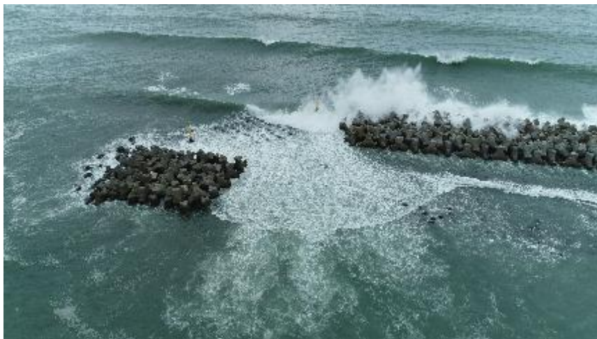
図 7 越波撮影 UAV 1
